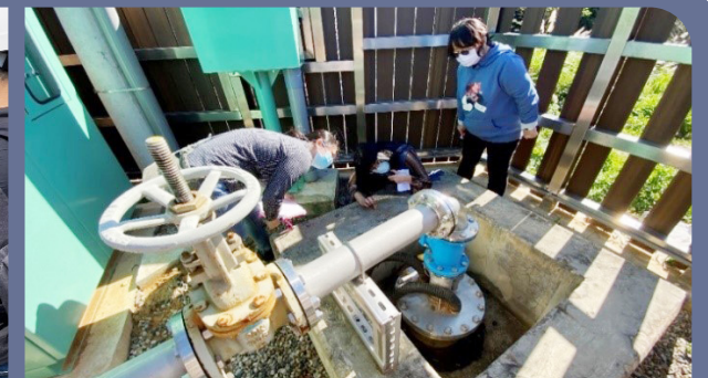
本校陪同進行既設抗旱井現場抽查作業情形
